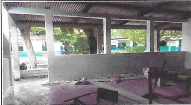
Foto 9: Repello y alizado dentro y fuera del salón II, de igual manera se estará instalando el sistema eléctrico colocando plafoneras y tomacorrientes y se estará pintando dentro y fuera del salón II.
