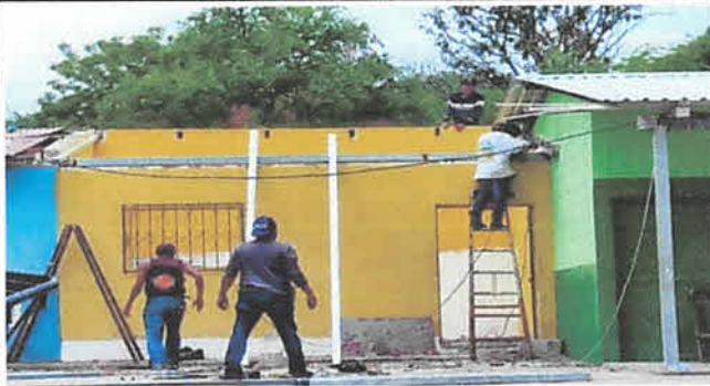
Foto 7: Cambio de techado con estructura de metal y lamina acanalada nueva para la Dirección del centro educativo.
