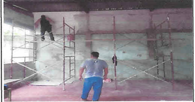
Foto 8: Repello y alizado dentro y fuera del salón I, de igual manera se estará instalando el sistema eléctrico colocando plafoneras y tomacorrientes y se estará pintando dentro y fuera del salón I.
