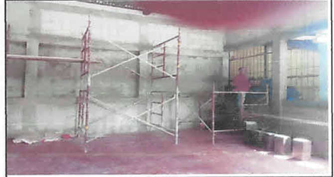
10: Sellado de las dos ventanas del salón II
